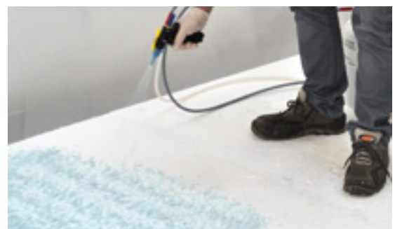
Fig. 2: La colle 81065 est pulvérisée sur le support à l'aide d'un pistolet de pulvérisation.
