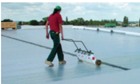
Fig. 1: Mise en place semi-automatique de la colle polyuréthane 81068.
