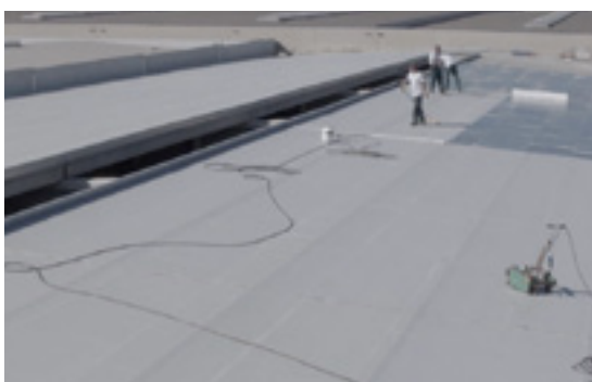
Tabaksnatie (Belgique): Encollage avec RENOLIT DUALFIX
